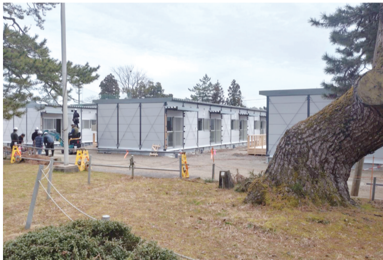
这是4月1日在日本石川县珠洲市上户町拍摄的正在建设中的临时安置房。
