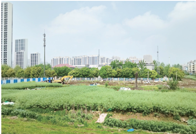
迎江区闲置地块整治现场。全媒体记者 雷琳琳 摄
