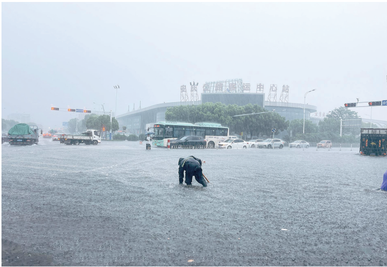
2024年7月13日,安庆遭遇一轮强暴雨袭击,当日,市政工作人员正在疏通雨水井。(资料图片) 全媒体记者 徐志远 摄
