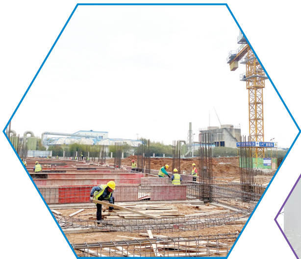
▲ 依江新能源汽车零部件产业基地B区项目现场。 ► 富森科技(安徽)有限公司年产44.5万吨水溶性高分子项目现场。
