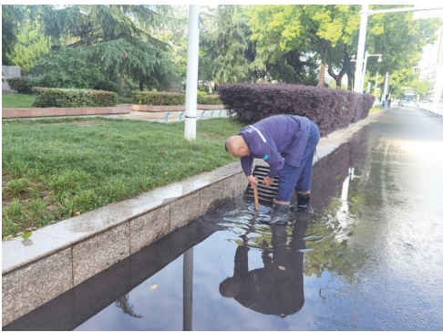
工作人员对堵塞的雨水井进行清掏
