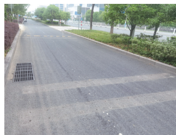
施工方已拆除部分减速带。
