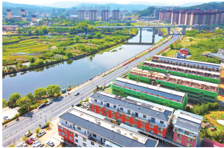
4月26日,岳西县一安置区项目建设现场,工人们正在加紧施工,与道路、河流交相辉映,构成一幅美丽画卷。
