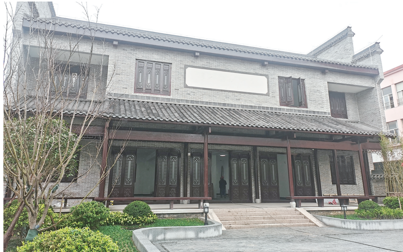
赵朴初故居周边空间整治提升项目。
