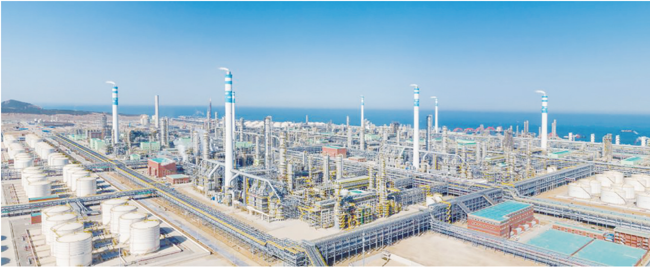
恒力石化大连炼化一体化项目。
