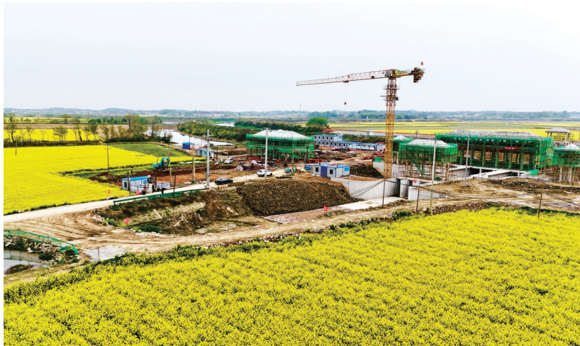
4月1日,怀宁县石牌镇万全电排站正在进行机电安装。该排电站是市级重点工程,总投资4000余万元,承担着周边五个村共1.5万余亩的排水任务。预计4月底建成投入使用。 通讯员 詹志扬 张翔 摄
