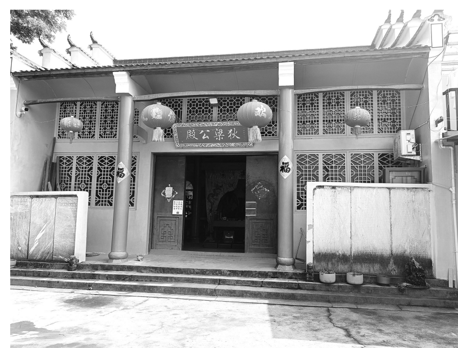
位于凉泉乡横山村的梁国公庙。 通讯员 吴小平 摄
