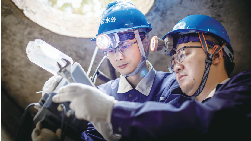
5月4日，工作人员正在巡查供水管井内的流量计。
