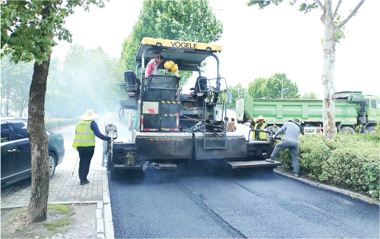
中山大道开展破损路面专项整治。 全媒体记者 徐志远 摄
