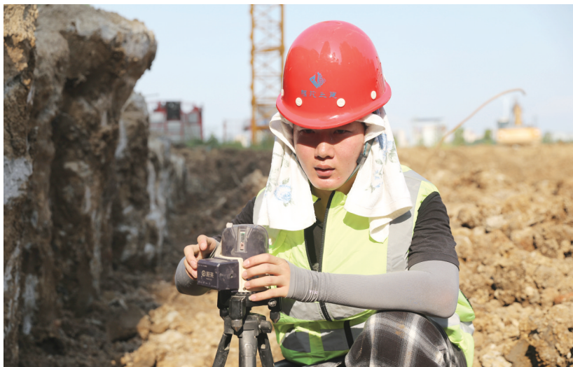
7月7日，宜秀区晴岚初级中学项目施工现场，建筑工人正冒着酷暑使用图线仪进行施工测量。当日，我市最高气温攀升至37.7℃，市气象台持续发布高温橙色预警信号。全媒体记者 徐火炬 通讯员 许莉 摄
