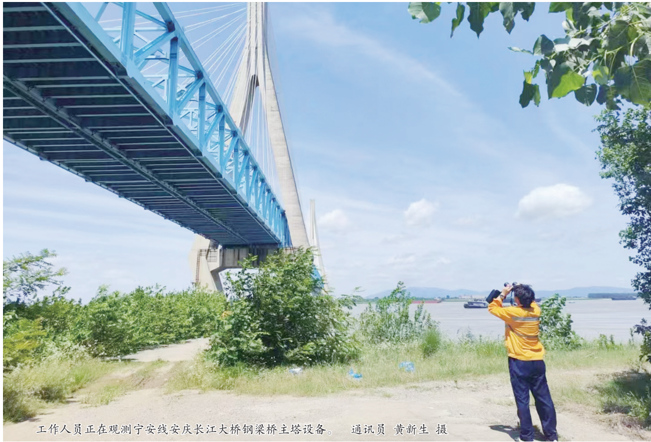
工作人员正在观测宁安线安庆长江大桥钢梁桥主塔设备。 通讯员 黄新生 摄
