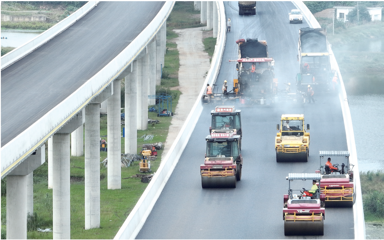
工人正在进行路面沥青施工。 通讯员 王永生 摄
