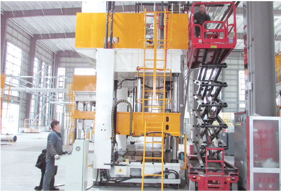
桐城市青草镇一家汽车零部件企业生产车间里，工人们正在加班加点赶订单。近年来，青草镇坚持工业强镇，盘活闲置厂房，实现“腾笼换鸟”，焕发新生机。 通讯员 黄健生 摄
