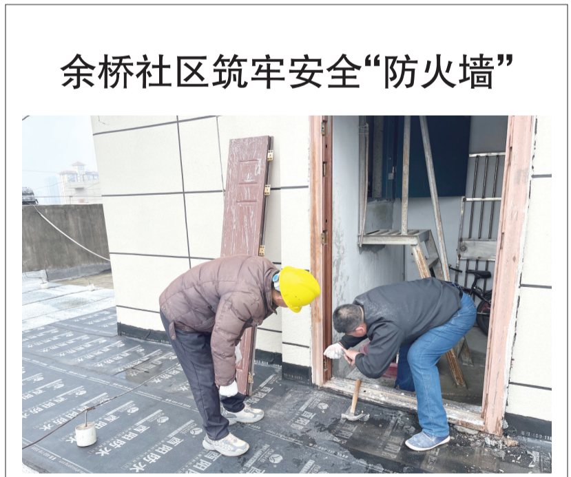
工作人员在余桥社区更换消防通道防火门。 通讯员 李辉 摄
