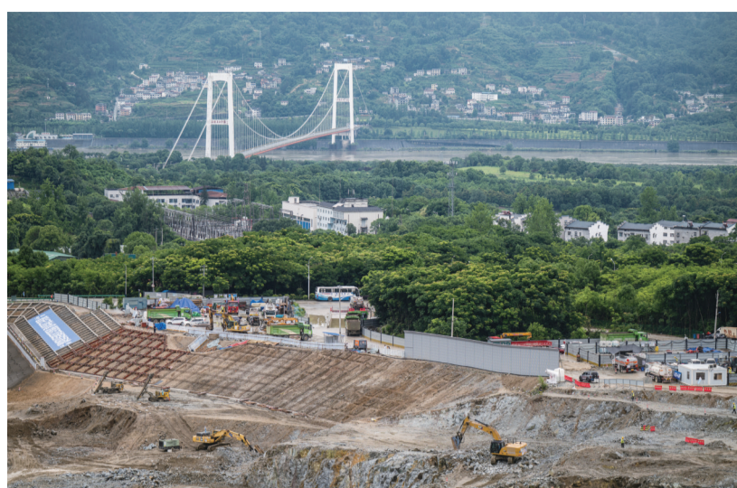
这是6月8日拍摄的三峡水运新通道工程先行开挖区施工现场。 新华社记者 伍志群 摄
