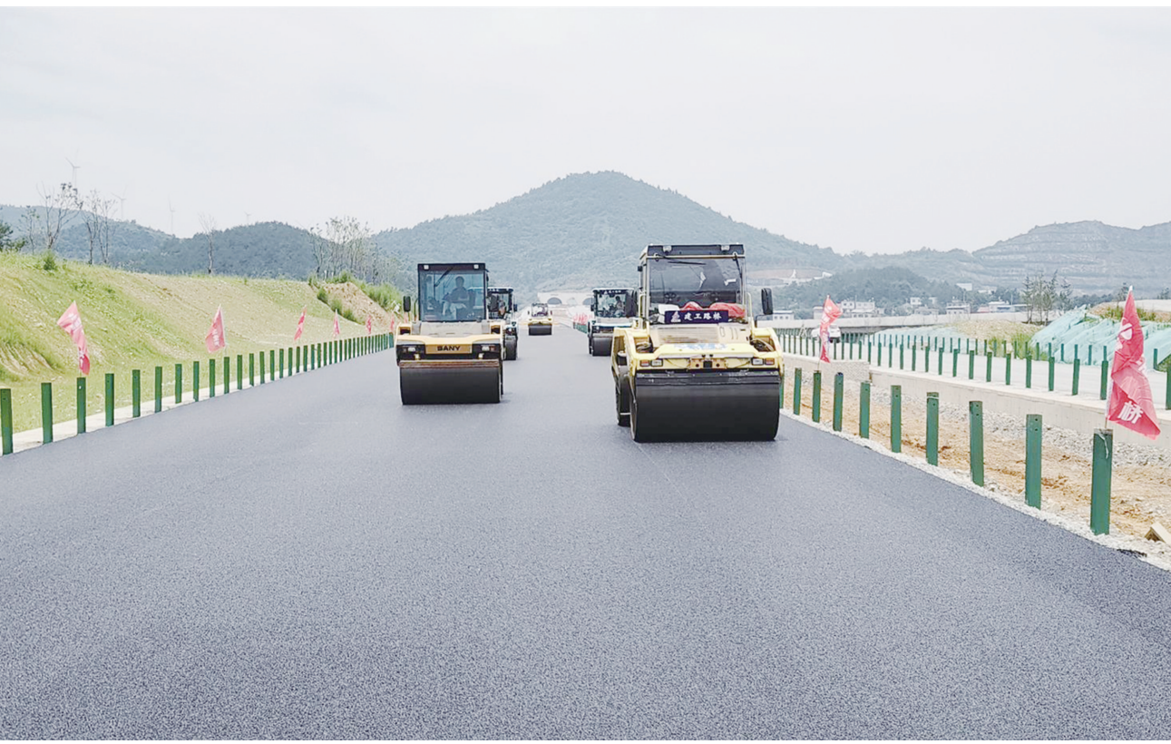
天天高速凉亭至月山段转入地面施工阶段。 通讯员 赵锐 摄
