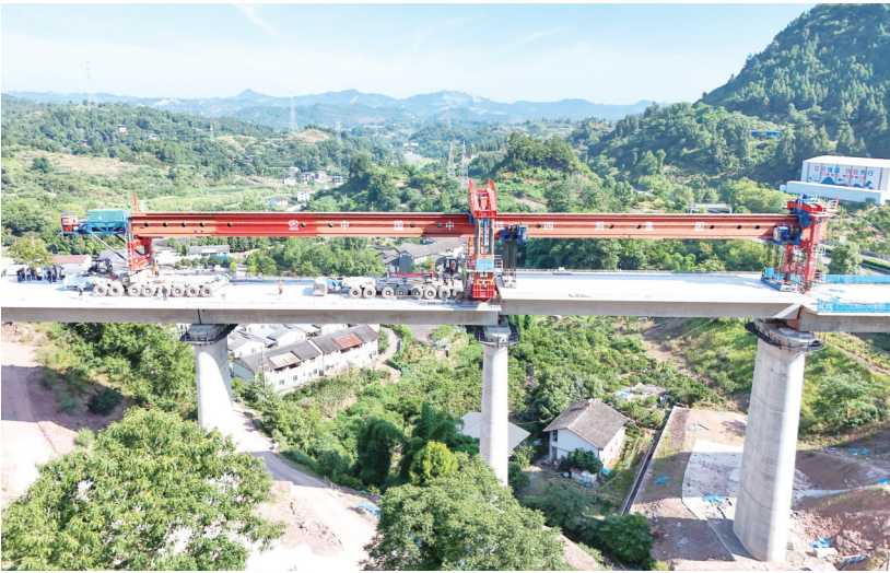
7月14日，最后一孔长32米、重约700吨的箱梁精准落位四川省达州市境内的西渝高铁邻川村跨恩广高速公路大桥桥墩，标志着西渝高铁全线箱梁架设任务顺利完成。为全线按期通车奠定坚实基础。新华社记者 王曦 摄
