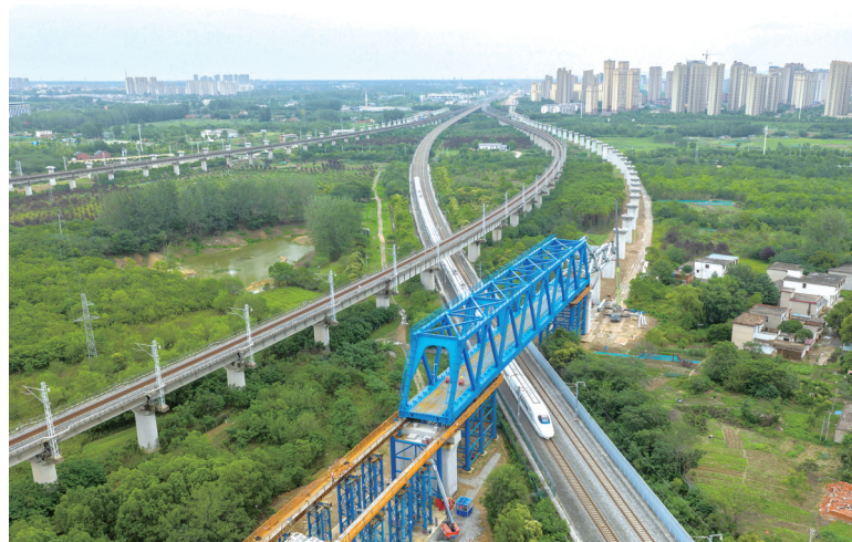
新建沪宁合高铁钢桁梁跨越沪蓉铁路（6月15日摄，无人机照片）。
