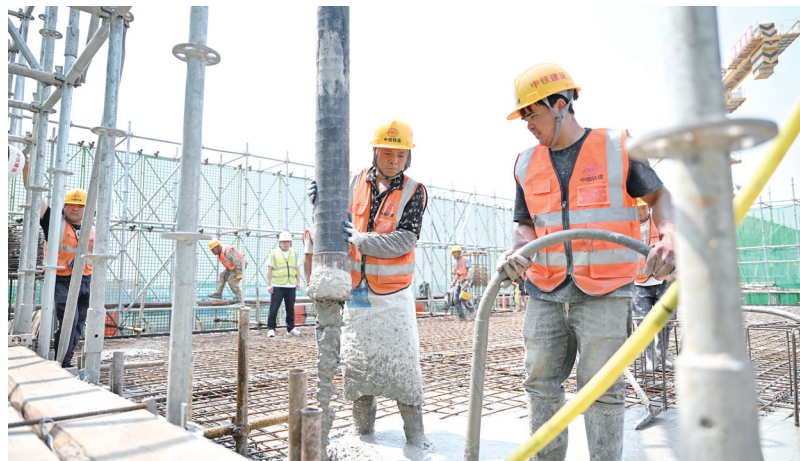
6月18日,中铁建设集团工人在雄忻高铁望都北站建设现场浇筑水泥。
