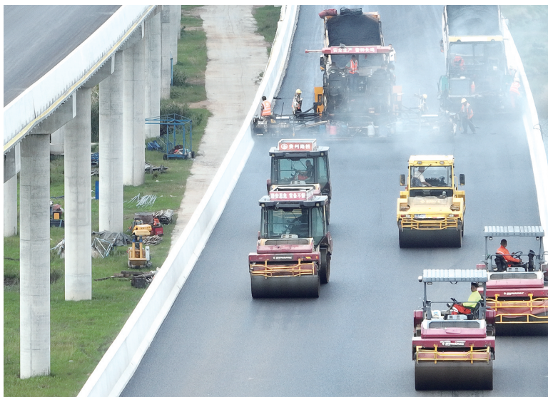
工人们正在进行工程路面沥青施工。
