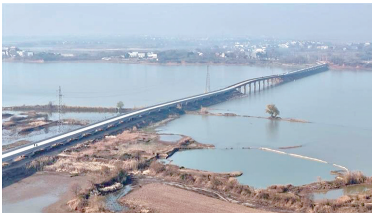
宿松周墩二桥完成农村公路危桥治理。
