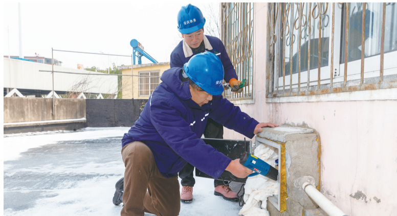
供水服务人员为集贤苑3号楼一单元用户水表进行解冻。
