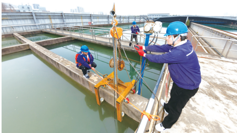
工作人员进行反应池底部筛沙作业试验。
