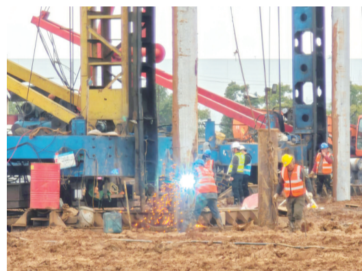
经开区年产20GWh动力电池项目建设现场。
