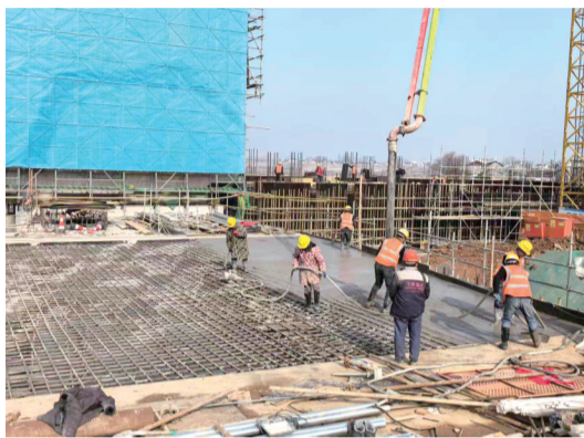
望江标段华阳河泵站项目施工现场。
