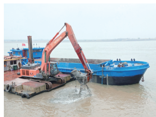
安庆码头改扩建工程施工现场。
