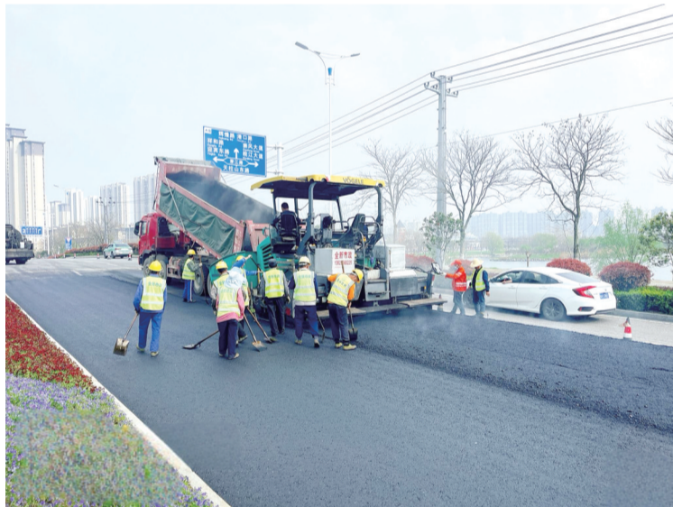
整治桥头沉降路面施工现场。
