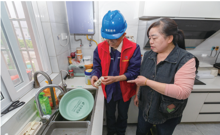
维修师傅上门为用户陈大姐家检查维护供水设施。
