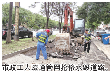
市政工人疏通管网抢修水毁道路。
