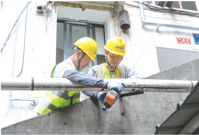
施工人员在更换该片区供水楼前支管。
