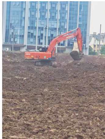
▲施工现场,正在作业。
