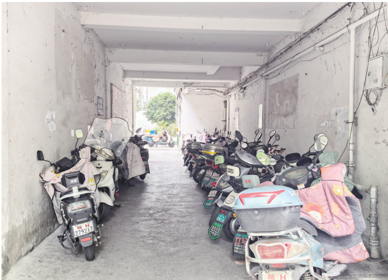
菱建小区楼道内停放的电动车。
