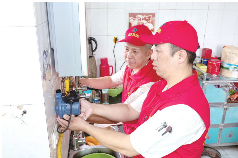
维修人员正在为用户家加装供水增压泵 通讯员 颜春骏 摄影
