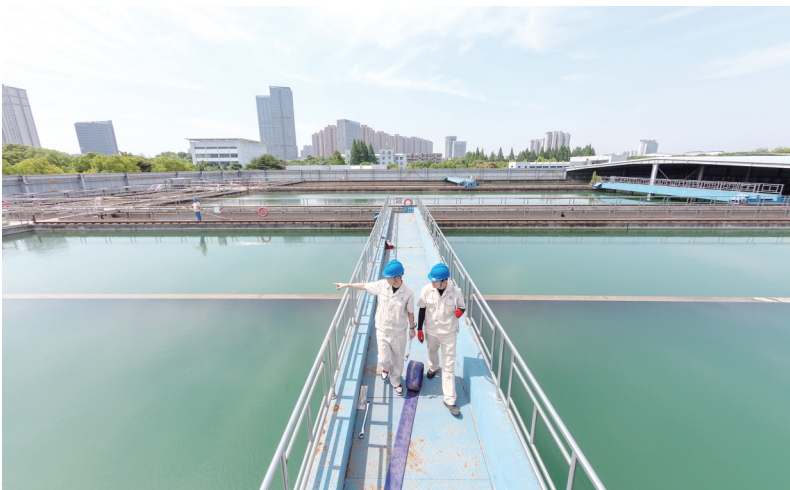
制水生产人员正在池面进行生产安全巡检。
