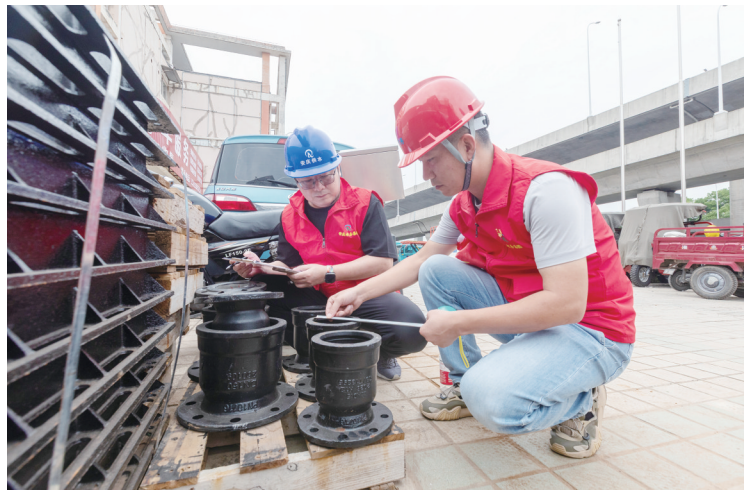
物资采购和施工双方正在抽检安装材料质量。
