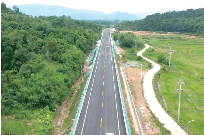
S465 罗湖大桥接线工程建成通车
