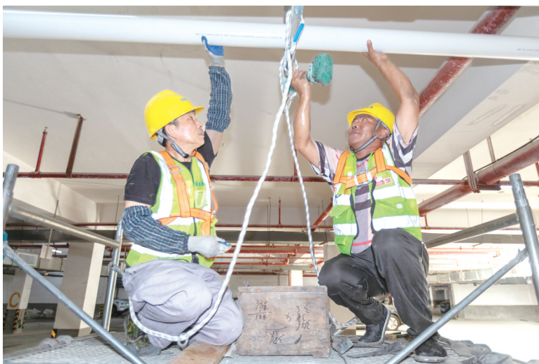
施工人员正在地下车库安装供水管。
